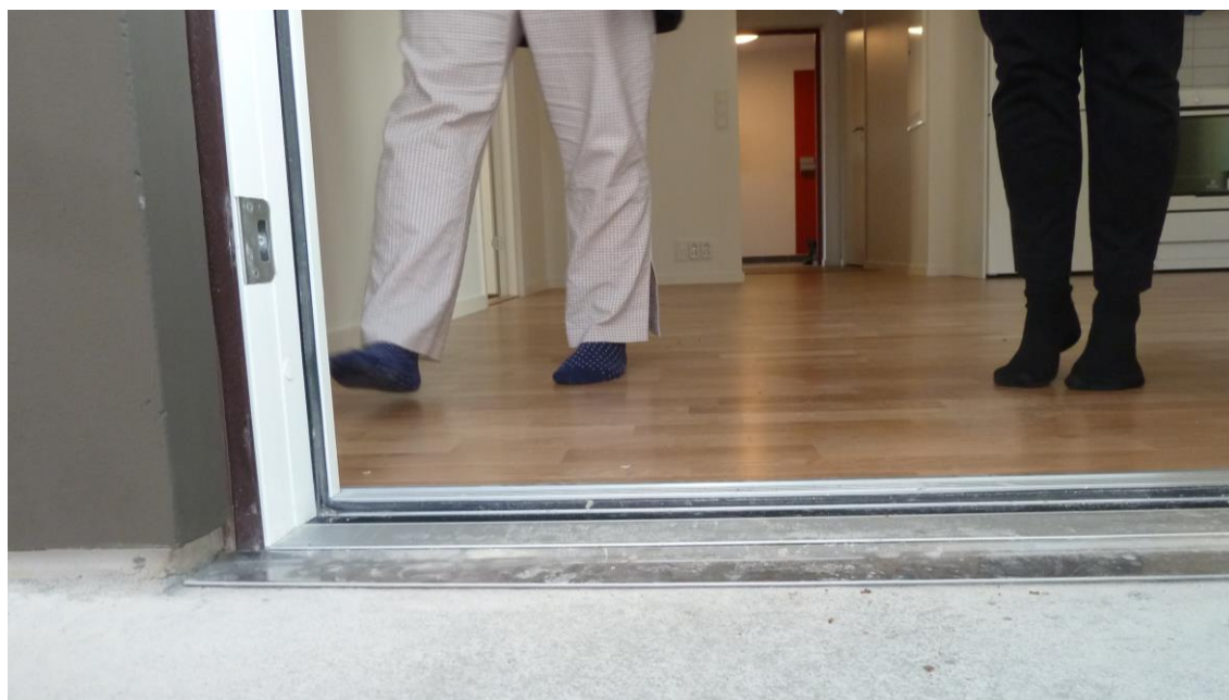
Låg tröskel ut mot en inglasad balkong.
